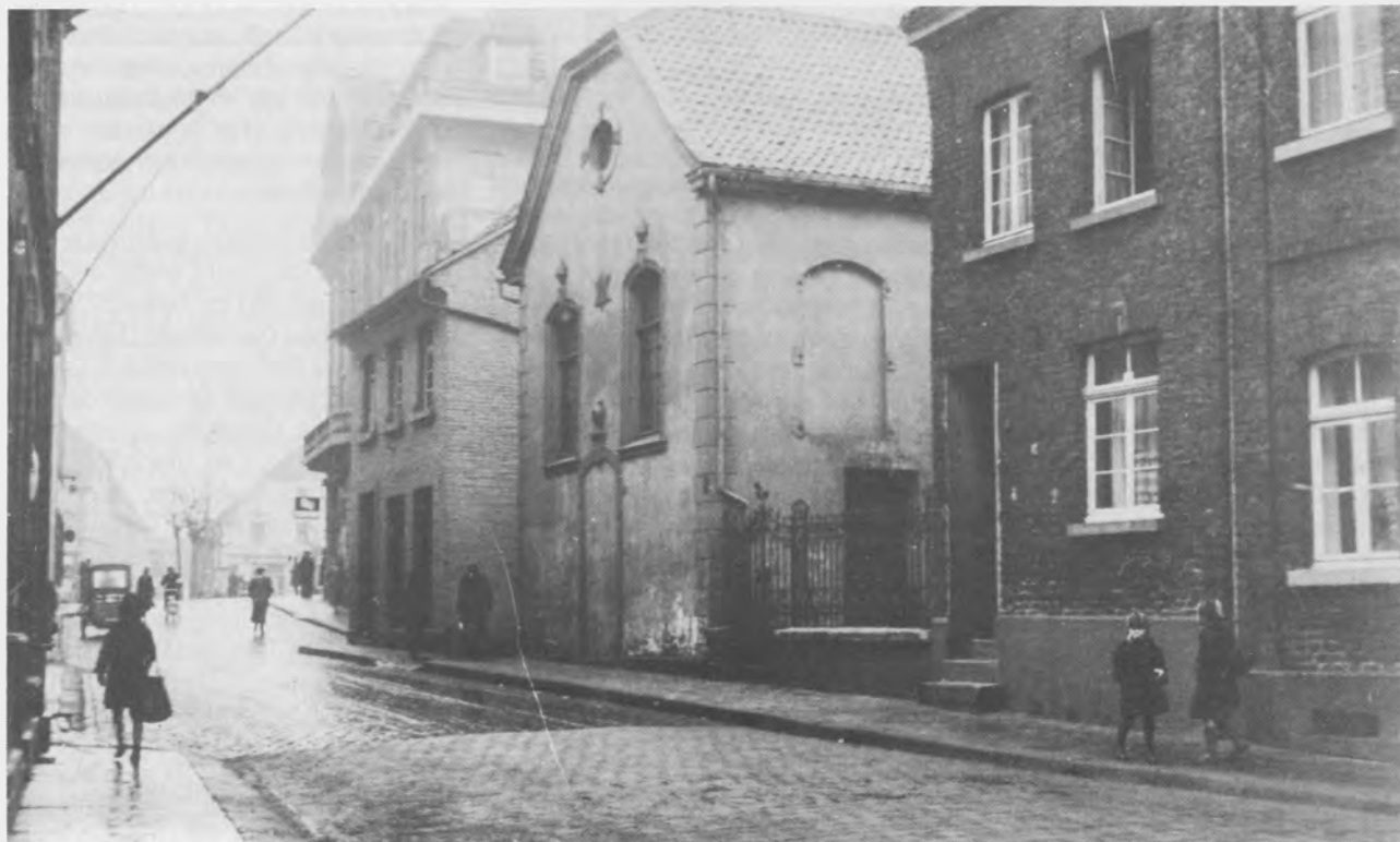
Die Ratinger Synagoge wurde, nachdem sie schon seit Jahren nicht mehr als Bethaus gedient hatte, 1936 an die Stadt verkauft und dann während des Krieges abgebrochen. Die heutige Bebauung an der Becherner Straße erfolgte erst 1958.
